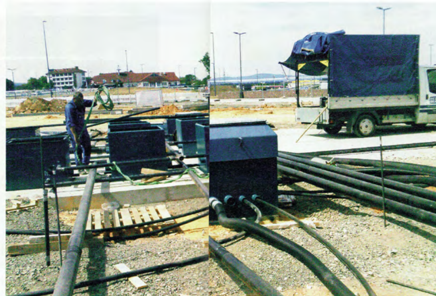
Geisler zeichnet für den Neubau der Tankanlagen und Rohrleitungen für die Autobahntankstelle Kassel-Ost, Teil der künftig einseitigen Tank- und Rastanlage, verantwortlich.
